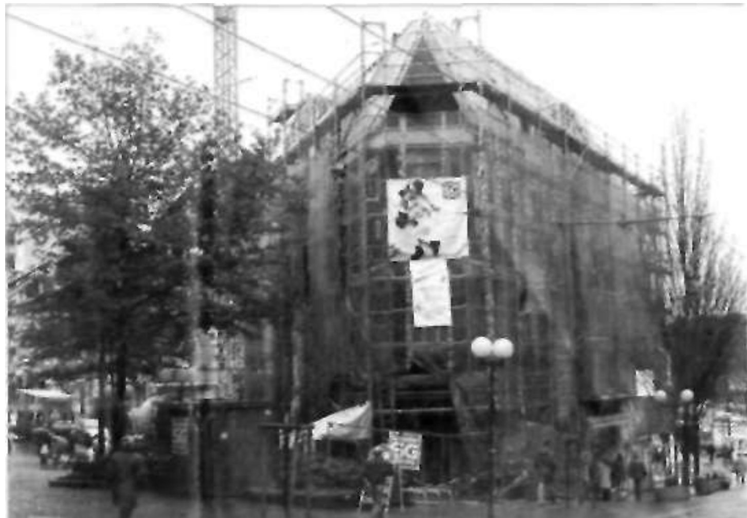
Planen verhüllen die Großbaustelle im Borbecker Zentrum. Mitte des Jahres sollen sie fallen.
